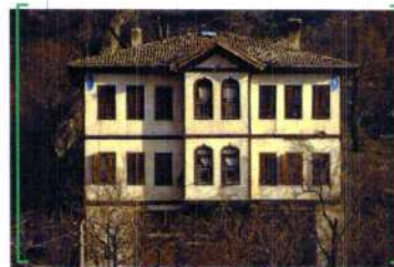
Safranbolu Şehri Tarihi mekan
